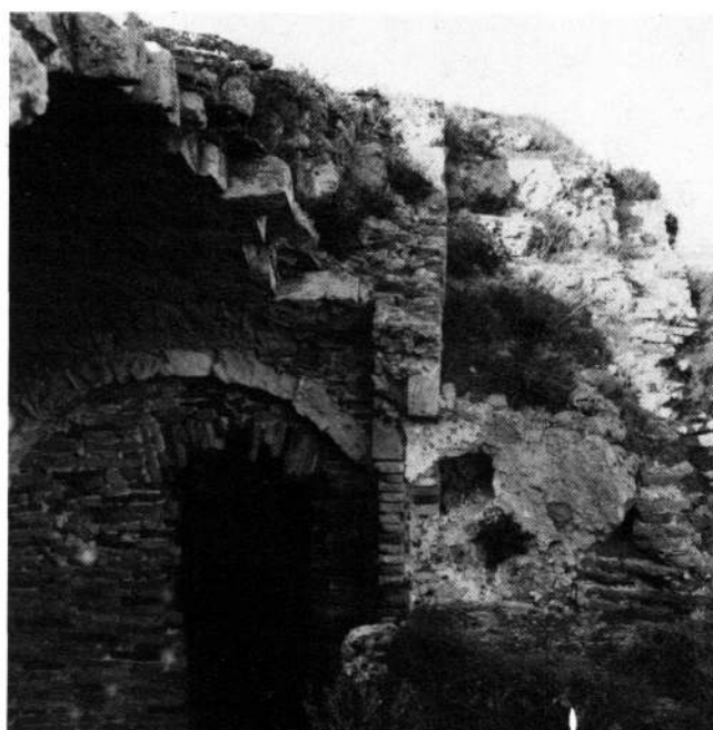
40. Torre Mattoni. Particolare degli ambienti crollati e della muratura esterna.
