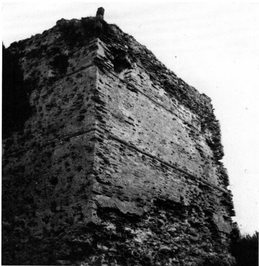
38. Torre Mattoni. Particolare della parete costa-ovest.
